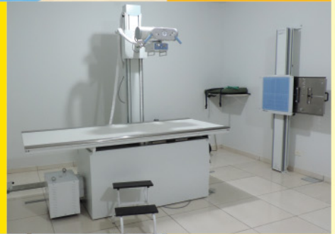
Reforma e readequação do Hospital Municipal com a conclusão da sala de Raios-X (equipamento novo)
