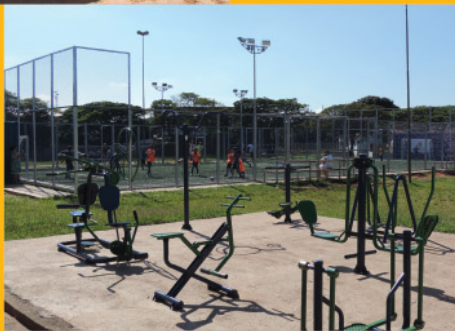
Revitalização da praça e instalação de mini arena esportiva no Conjunto João Urbano.
