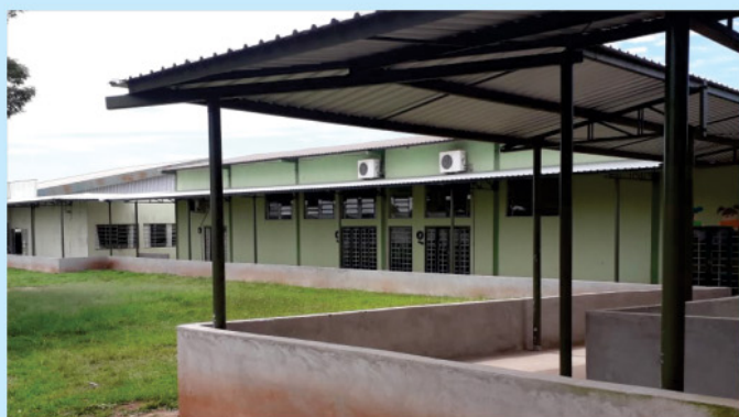
Instalação de passarelas cobertas interligando blocos nas escolas Júlio Benatti e Jorge Faneco.
